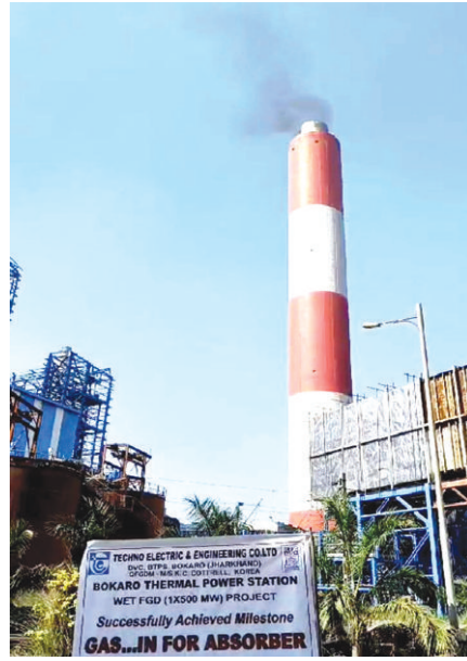
400 करोड़ की लागत से हुआ है निर्माण पर्यावरण के नये मापदंड को लागू करने तथा प्रदूषण नियंत्रण को लेकर बोकारो थर्मल स्थित डीवीसी के 500 मेगावाट के पावर प्लांट में अलग से 400 करोड़ की लागत
